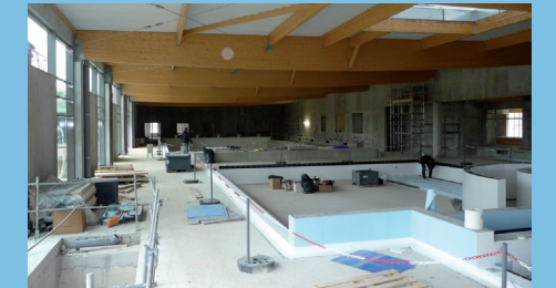
Vue du bassin de la piscine qui ouvrira au printemps
